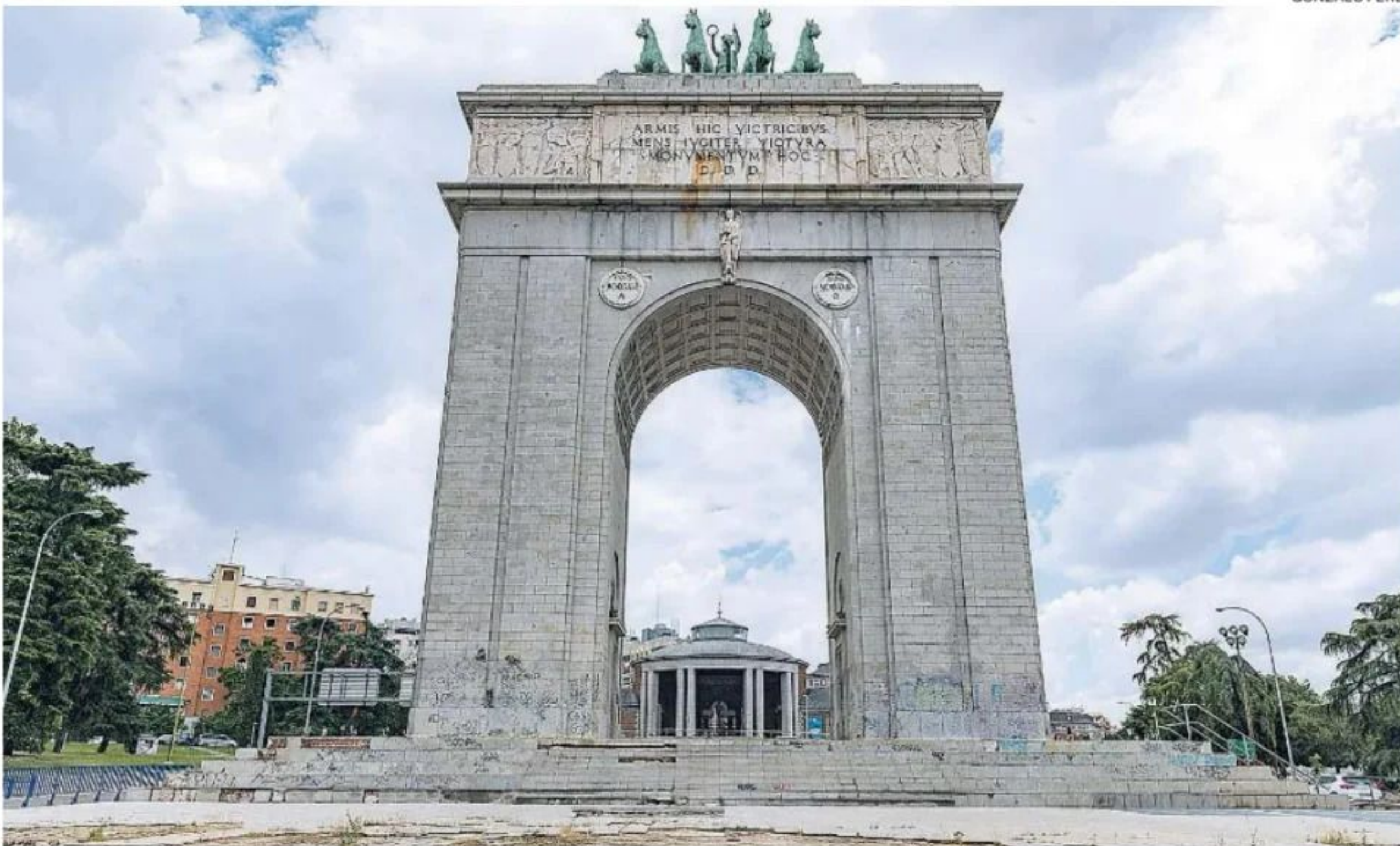
El Arco de la Victoria de Moncloa ha sufrido un progresivo deterioro en las últimas décadas
